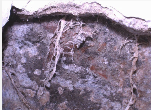
Stränge unter dem Putz
